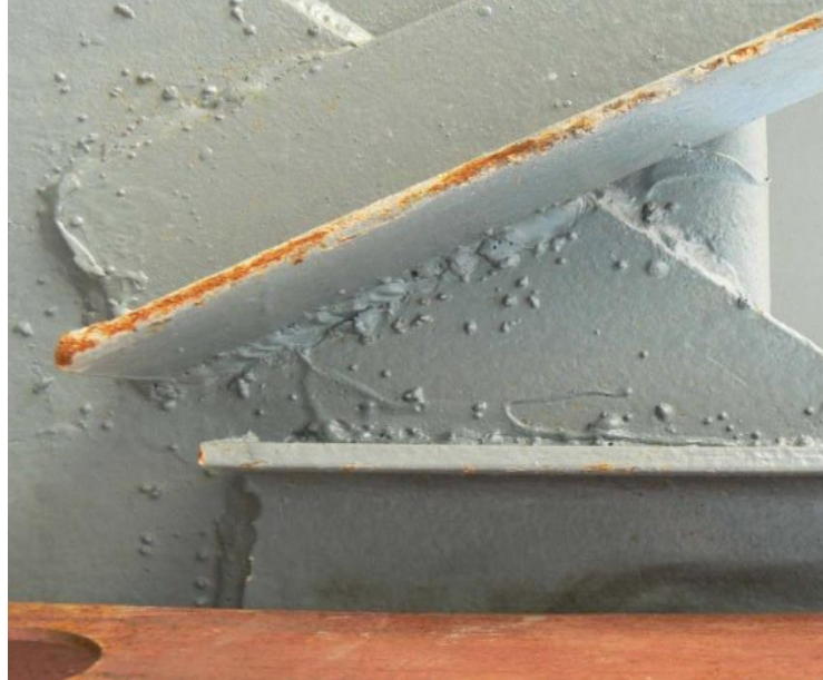
Figura 38 – Excesso de respingos II. Fonte: SANCHES, 2010.
