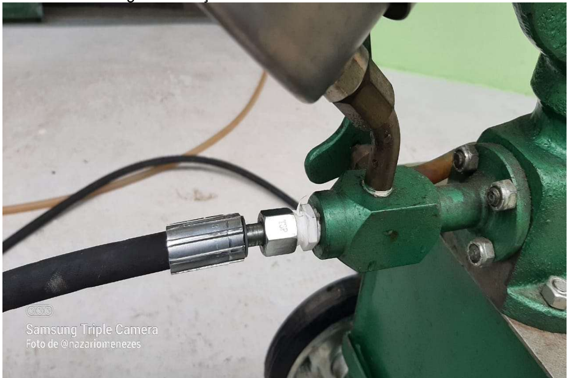
Imagem: Vedação das conexões com fita veda-rosca
