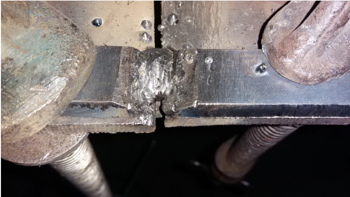
Figura 22: Execução da soldagem. Fonte: Elaborada pelo autor
