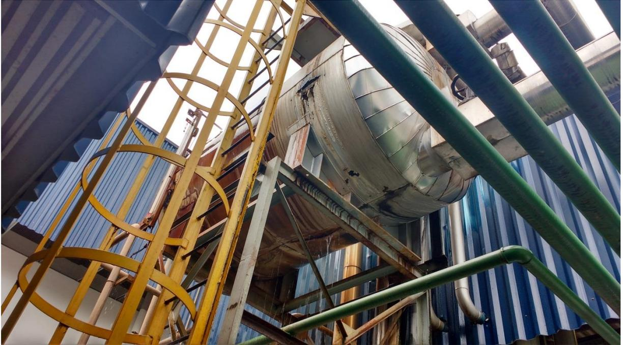
Figura 22: Tanque de retorno de condensado da empresa em questão. Fonte: Autor.
