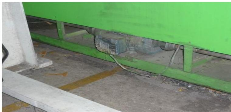
Figura 10: Parte Elétrica Exposta. Fonte: International Paper (2017).
