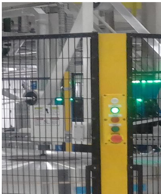
Figura 52- Painel de Segurança a ser Instalado no Sistema de Desbobinador, Carro de Controle e Tombador.
