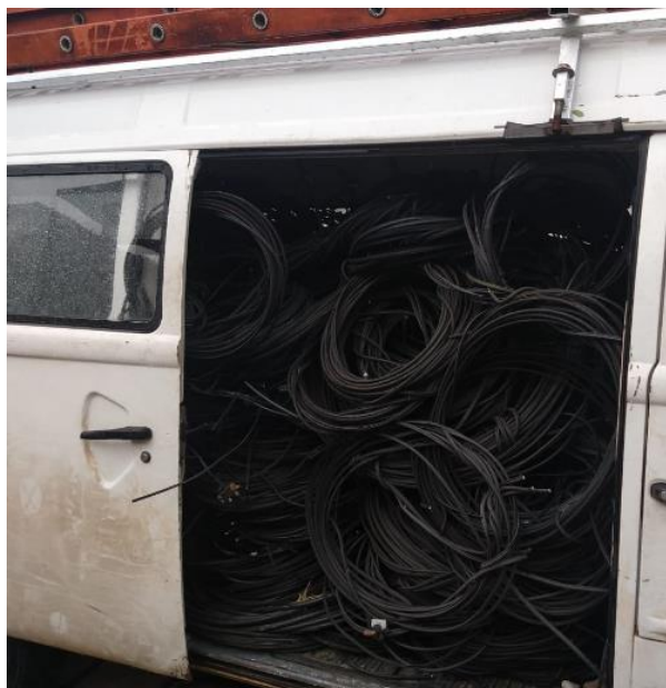
Figura 28: Volume de cabos coletados depois da higienização do Node.
