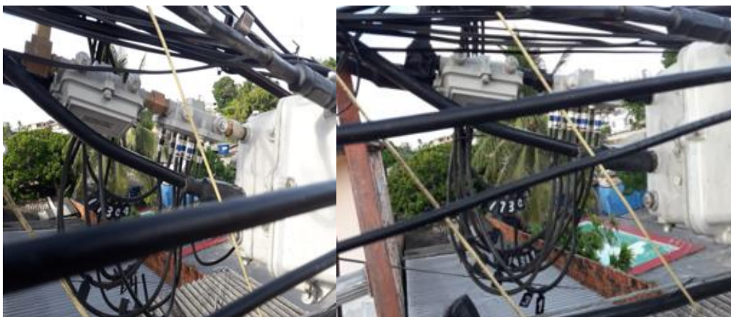
Figura 27: Antes e depois da higienização do TAP e isolamento de conexão.
