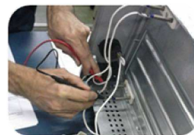
Realizando medidas com o multímetro.
