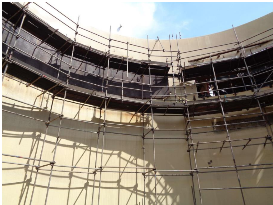
Figura 33- Substituição de chapas metálicas e aplicação de pintura no tanque G-03
