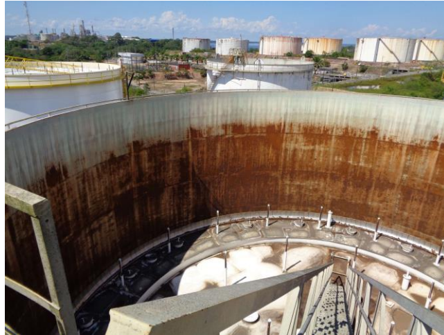
Figura 26- Vista do lado interno do tanque G-03
