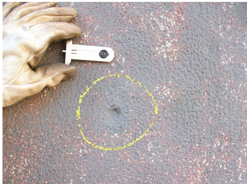
Figura 32- Medição de profundidade de alvéolos no costado do tanque
