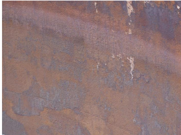
Figura 31 – Vista aproximada da superfície interna do 4º anel do costado do tanque G-03
