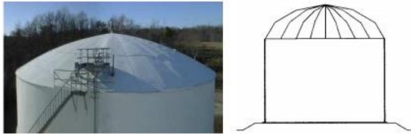
Figura 13- Vista de um tanque de teto em gomos
