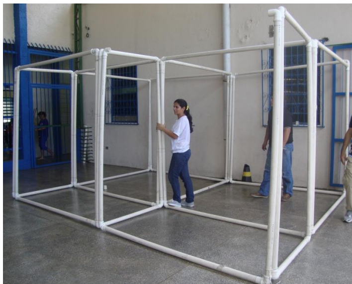
Figura 3. Estrutura montada com tubos de PVC. Fonte: A própria autora.
