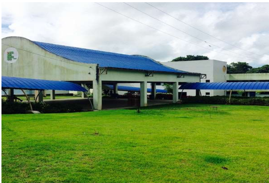
Figura 3 - Fotografia parcial da área de convivência e salas de aula.
