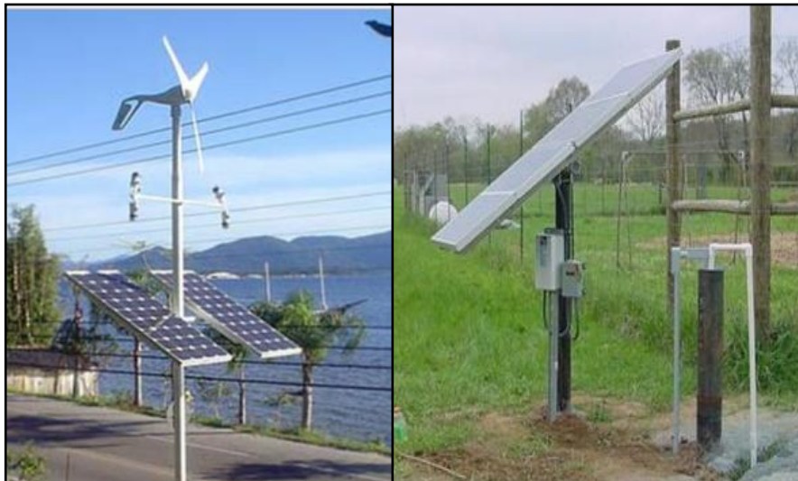
Figura 06- Sistema Híbrido (à esquerda) e Autônomo (à direita)
