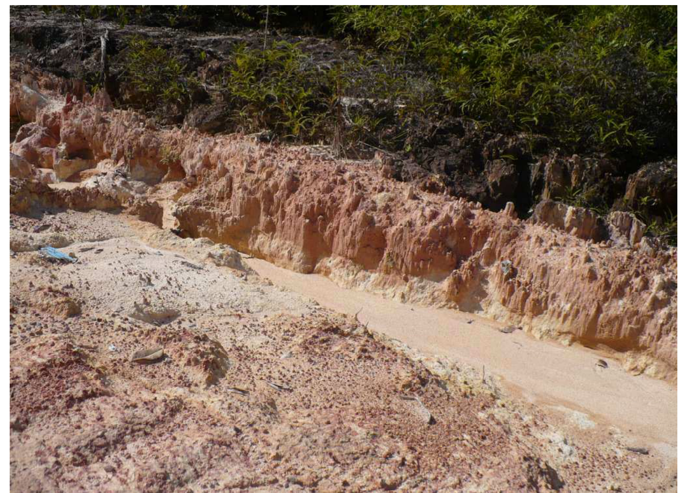
Figura 15. Erosão do tipo voçoroca localizada no Km 60 da BR - 174, Manaus/AM
