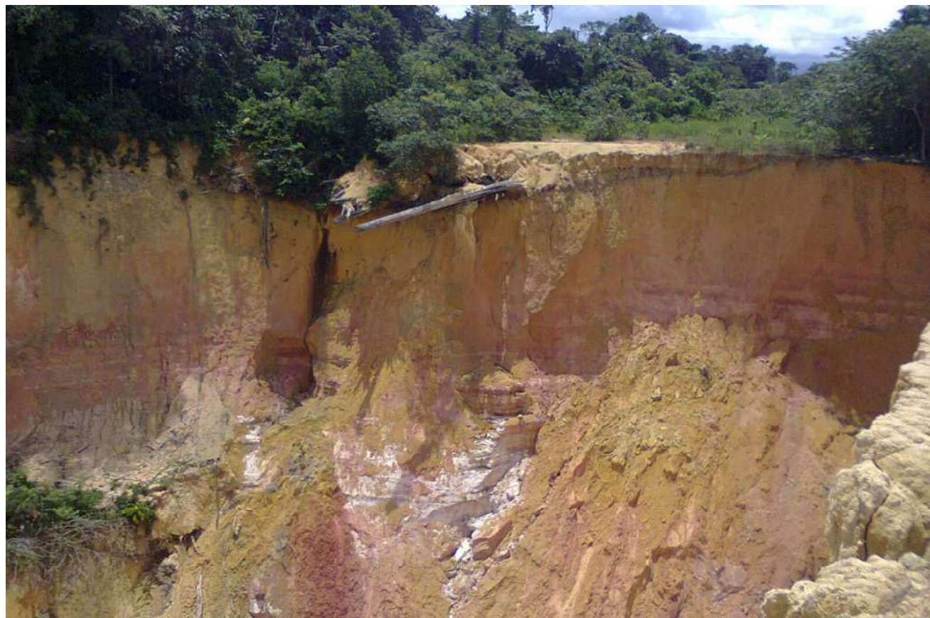
Figura 14. Queda em bloco de solo originando erosão do tipo voçoroca localizada no Distrito Industrial II, Manaus/AM
