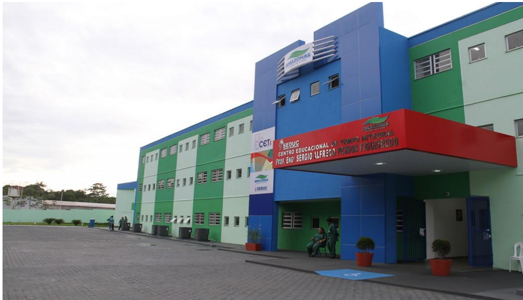
Figura 1 – Fachada da escola Ceti Eng. Prof. Sérgio Alfredo Pessoa Figueiredo
