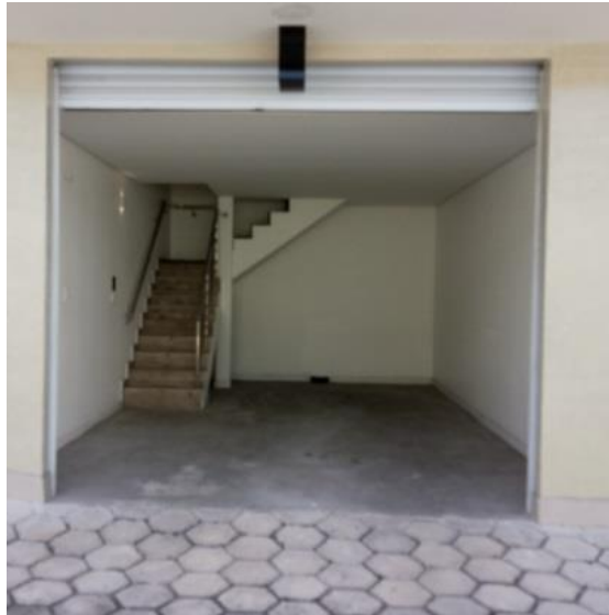
Figura 45 – Portão da garagem aberto.
