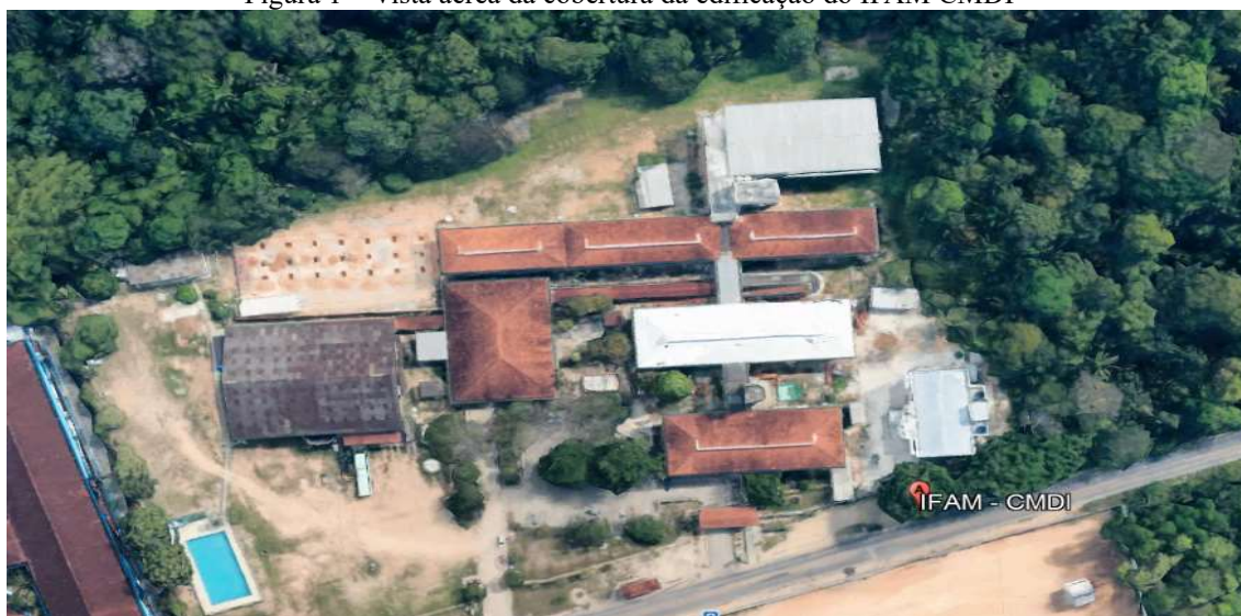
Figura 1 – Vista aérea da cobertura da edificação do IFAM CMDI
