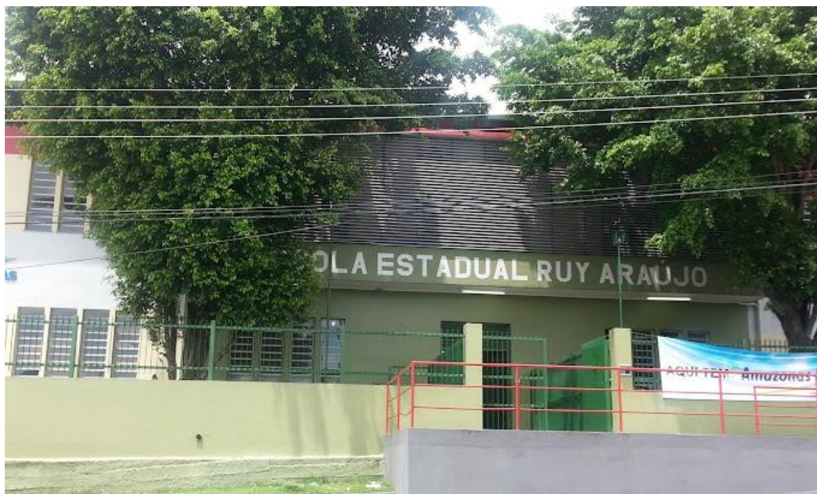
Figura 3 - Fachada da Escola Estadual Ruy Araújo
