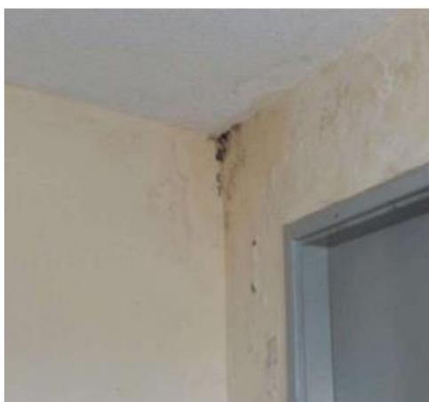
FIGURA 2: EXEMPLO DE INFILTRAÇÃO – VISTA B
