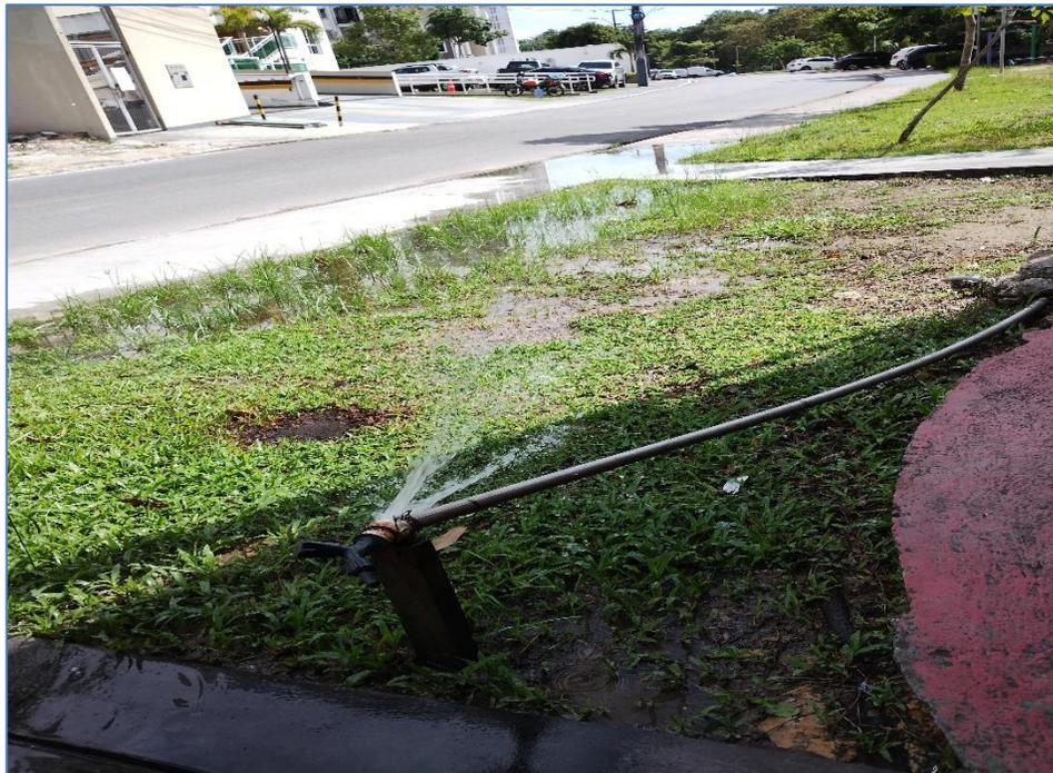
**Figura 1** - Vazamento de água.
