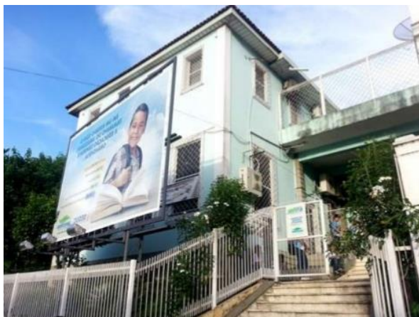
Figura 2 - Fachada da antiga Escola Augusto Carneiro dos Santos
