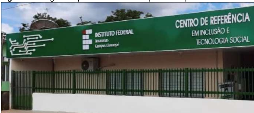
Figura 4 - Imagem do prédio do IFAM/Campus Eirunepé
