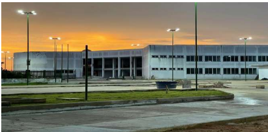
Figura 5 - Imagem do prédio oficial do IFAM/Campus Eirunepé
