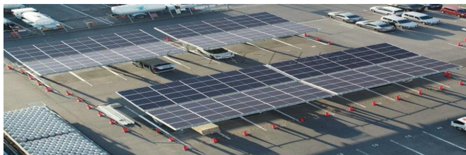
Figura 106 – Uso do Carport Solar em Estacionamento
