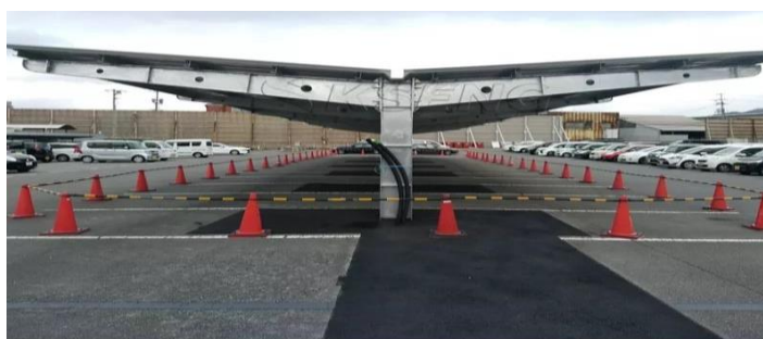
Figura 114 – Estrutura de um Carport Solar
