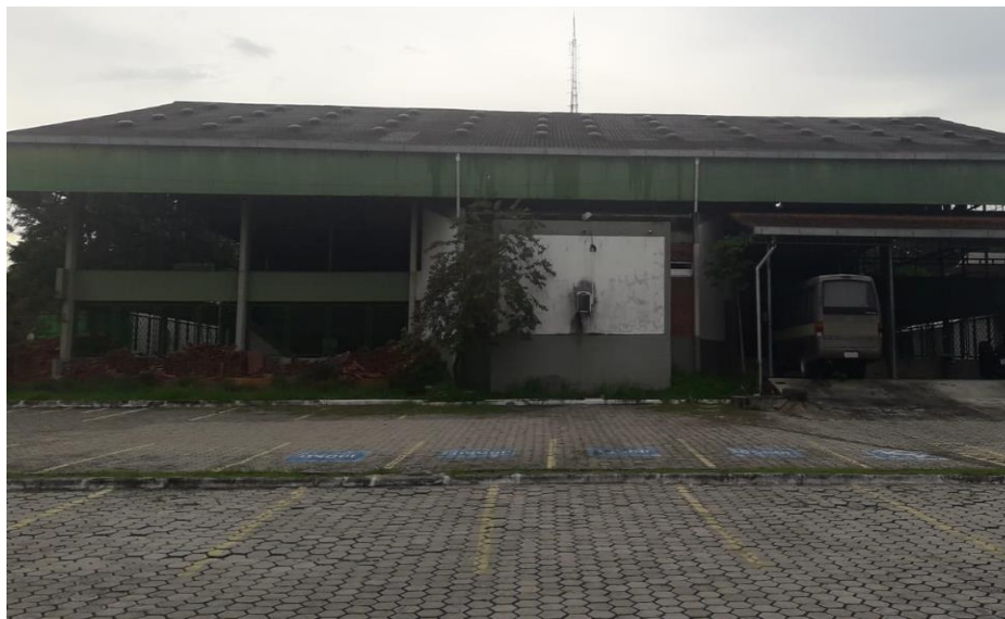
Figura 217 – Area de Instalação dos Inversores
