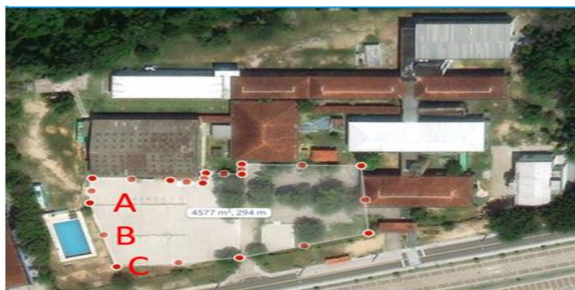
Figura 118 - Estudo do Local para a Instalação dos Paineis Solares
