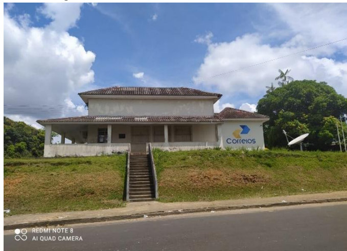
Figura 6: Prédio dos Correios atualmente.
