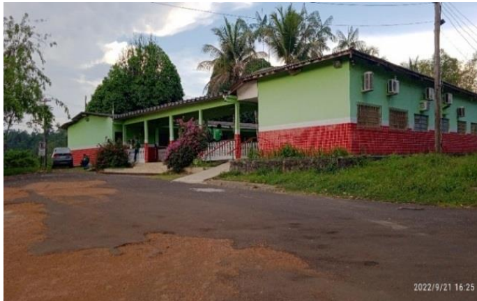
Figura 8: Prédio Pedagógico do IFAM/CSGC
