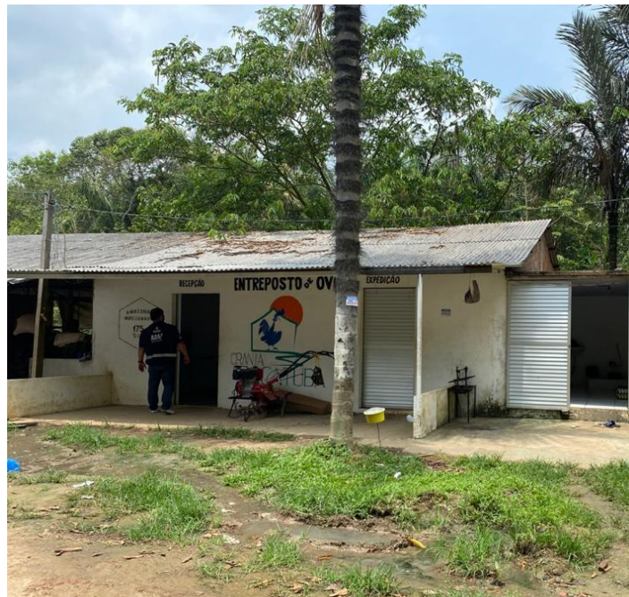
Figura 2 - Área externa sem acesso fácil para veículos.
