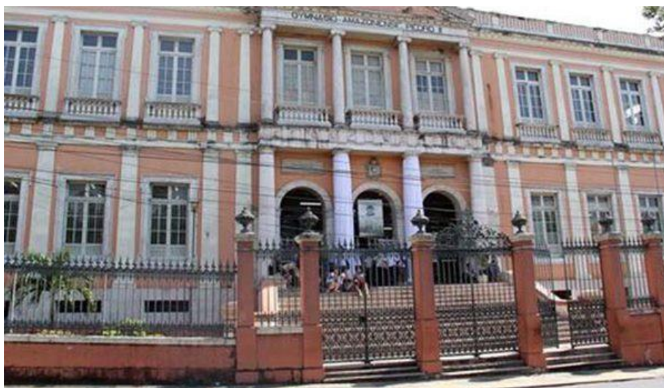
Figura 15: Fachada principal do Colégio Amazonense Dom Pedro II, localizado no Centro de Manaus;
