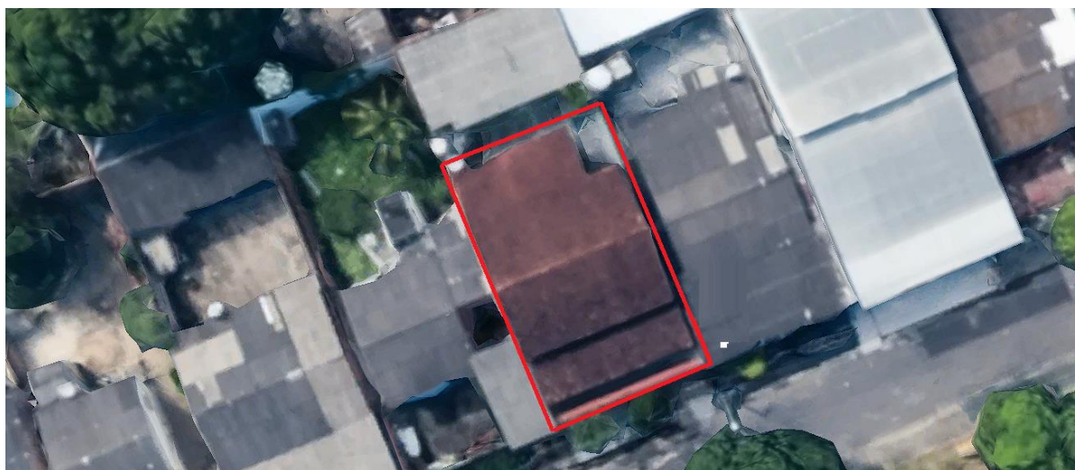
Figura 15 - Telhado do local estudado.
