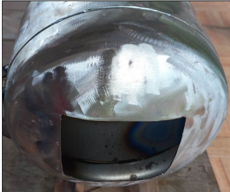
Figura 11: Estrutura após a retirada da tinta.
