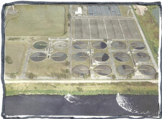
Estação de tratamento de esgoto
