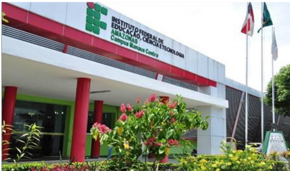
Figura 8: Fachada atual do IFAM – Campus Manaus Centro.
