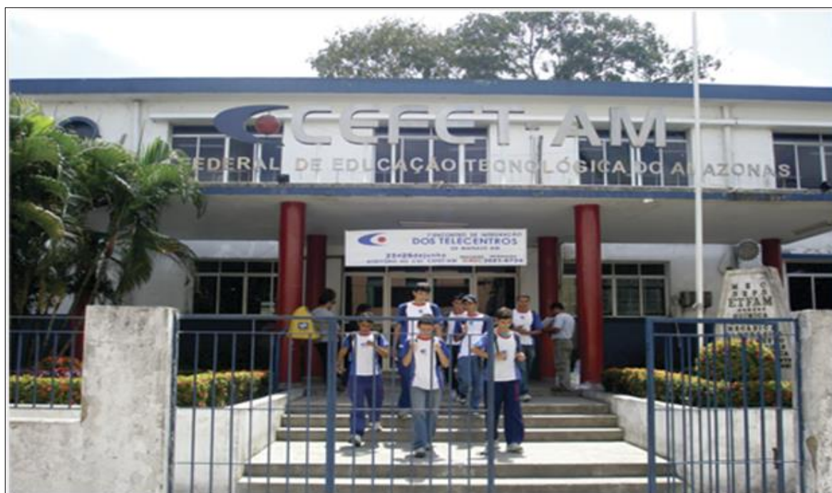
Figura 7: Fachada do CEFET-AM.
