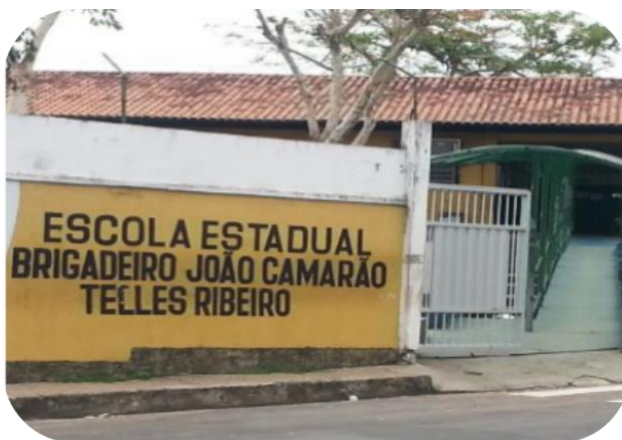
Figura 12: Vista da fachada da escola.
