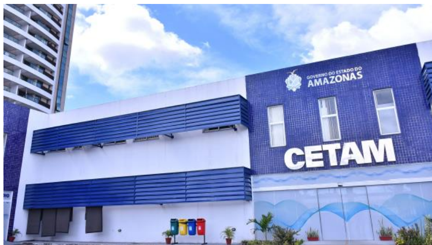
Figura 07 – Fachada do prédio da sede administrativa do Cetam em Manaus.
