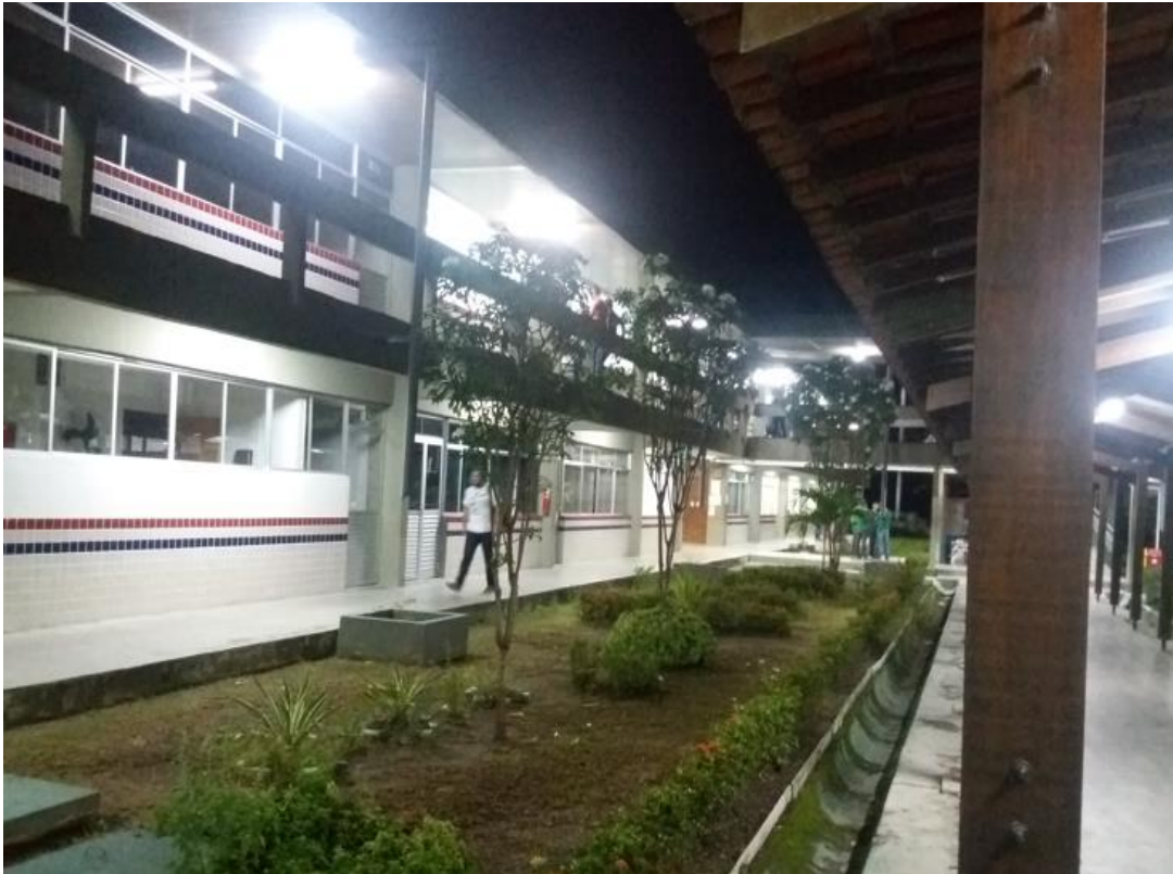
Figura 17 – Prédio de salas de aula.
