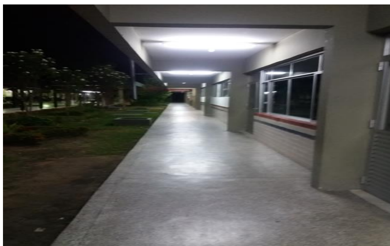
Figura 18 – Corredor do prédio.
